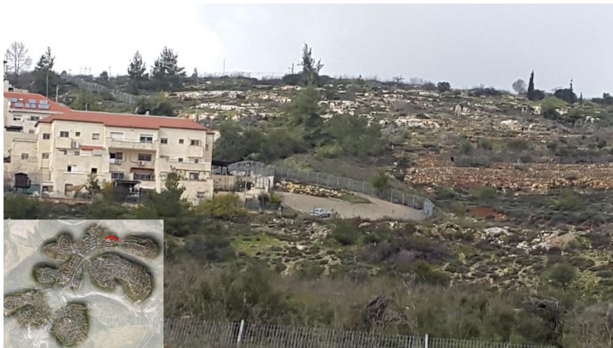
איור 16: קו המגע הצפוני של מבשרת ציון עם השטחים הפתוחים – מערך ציר וגדר ביטחון
