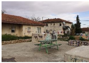
מרכז קליטה - מבנים בני 2 קומות עם גגות רעפים. מדרגות חיצוניות. כל מקבץ מבנים מאורגן סביב חצר פנימית.
