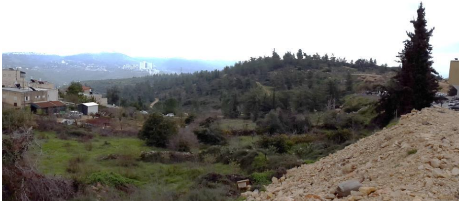
איור 14: קו המגע באזור התעשייה הקיים בהר חרת – שפכי עפר לכיוון השטח הפתוח, לא נעשה שימוש באמצעי פשוט של חישוף הקרקע הטבעית וחיפוי מדרונות
