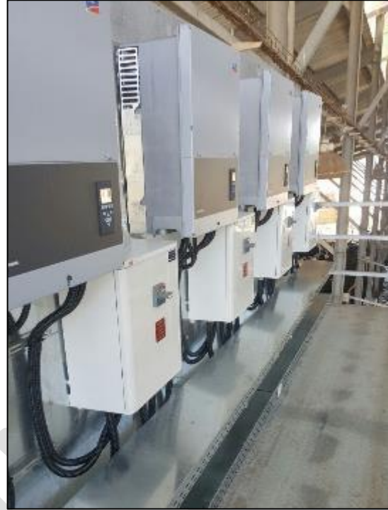
איור 4 : ממירים למערכות סולריות, ממירים את הזרם הישיר שמתקבל מהמודולים לזרם עקיף על מנת "לדבר באותה שפה" עם מערכת החשמל הארצית.
