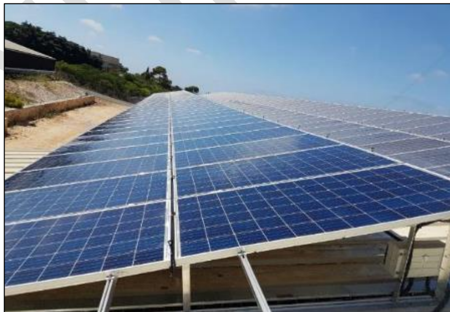
איור 2: מערך "מודולים" פוטו-וולטאים – קרינת השמש פוגעת בחומר המוליך למחצה ובכך משחררת אלקטרונים למערכת.
